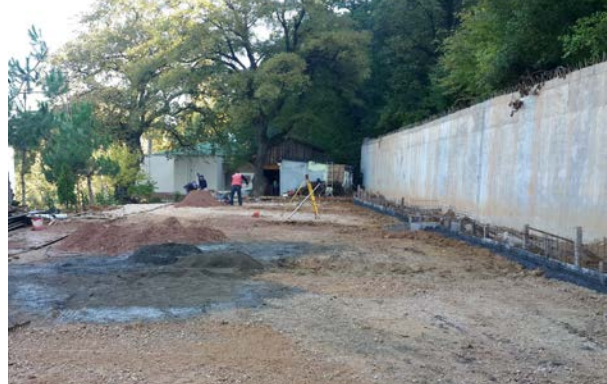
2-) Yıkılan bölümdeki kod farkı nedeniyle dağ tarafına yaklaşık 50 metre uzunluğunda 2metre yüksekliğinde istinad duvarı inşa edildi.
