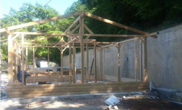
2-) Yıkılan bölümdeki kod farkı nedeniyle dağ tarafına yaklaşık 50 metre uzunluğunda 2metre yüksekliğinde istinad duvarı inşa edildi.
